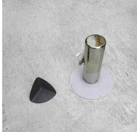
コーナーパッチ補修 脱気筒の追加補修工事
