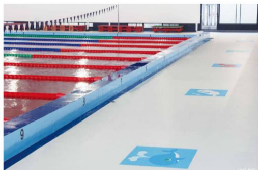
※従来サイズでのプールサイド施工例
