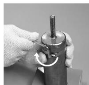
簡易工具でタイの端末を巻き込んで緊結します。 ※画像では防水層省略
