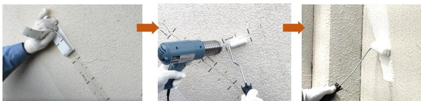
↑ A-NCテープ施工後、ヒートガンで所定の熱を加えることで既存テクスチャーになじみ、密着してひび割れを閉塞。柔軟性があることから、ひび割れ挙動にも追従します。
